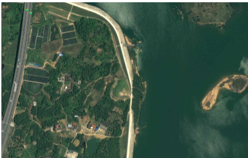
图 3-1-2 1#弃渣场 2020 年 12 月影像
