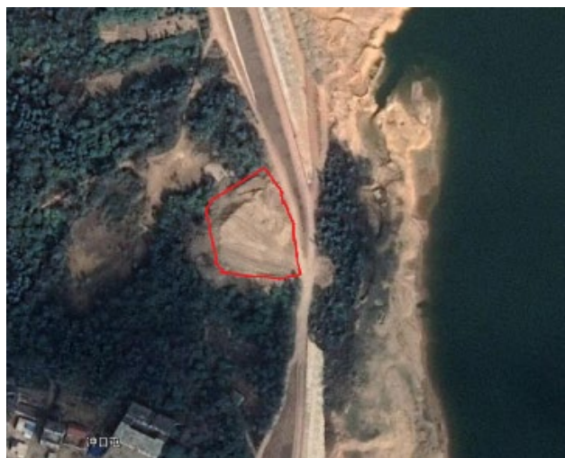
图 3-1-2 1#弃渣场 2020 年 12 月影像
